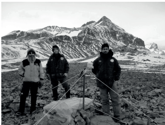
Figura 1 - Sensor para medir temperatura e umidade do solo e temperatura do ar instalado em Hope Bay, Península Antártica. Representa um dos pontos que compõe a rede de monitoramento do Núcleo TERRANTAR
