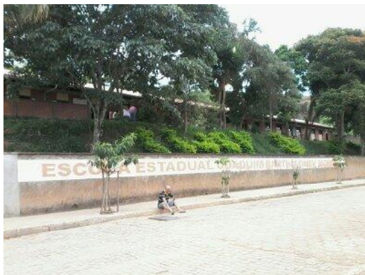
Figura 4 – Fachada da Escola Estadual Joaquim Bartholomeu Pedrosa
